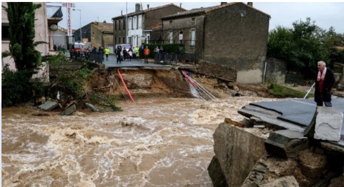
Crue Aude (2018) – 2 ponts effondrés et 10 sévèrement endommagés sur 82 analysés, soit un ratio de défaillance structurale des ponts, associé à l'évènement, de l'ordre de 15%
