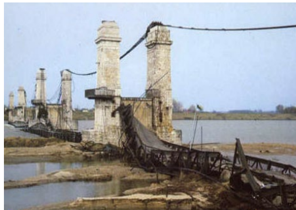
Pont de Sully-sur-Loire (1985) – Rupture fragile de câble par -22°C
