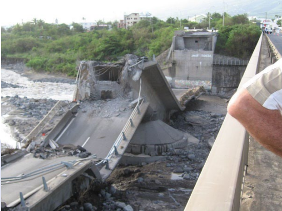
Pont riv. St-Etienne – La Réunion (2007) - Affouillement
