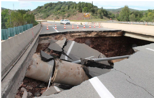
Effondrement buse du Bosc A75 (2015) – Episode torrentiel
