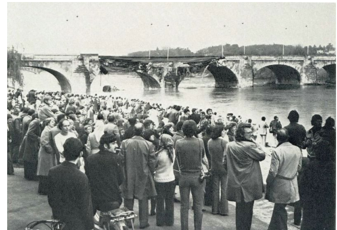
Effondrement du pont Wilson à Tours (1978) - Affouillement
