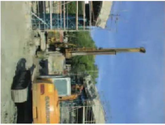
Photo 11 Exécution des pieux pile P1
