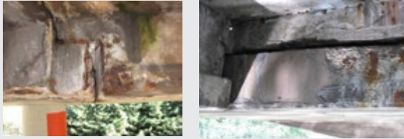
► Encadré 1 : Exemple de partie d'ouvrage souvent non visitable : les appuis d'un cantilever
