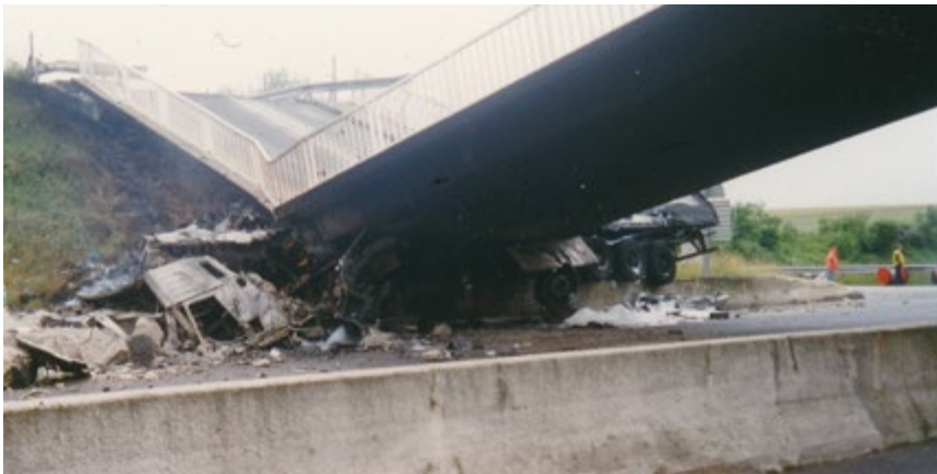
Choc sur pile aux conséquences « catastrophiques »
