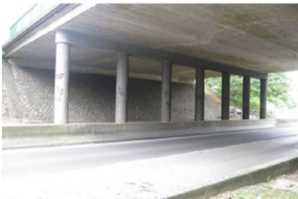
Exemple d'une pile comportant des fûts isolés
