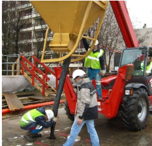
Moisage – blocs coulés en place : Le Mans
