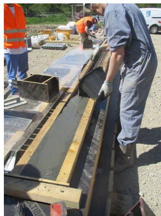
Moisage – blocs coulés en place : Le Mans
