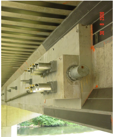
Moisage – blocs coulés en place : Le Mans
