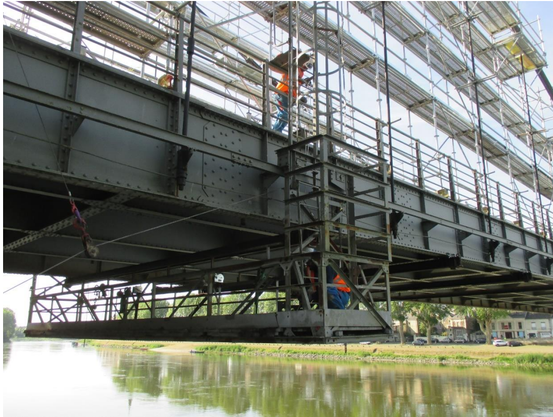
Remise en service de la passerelle sous ouvrage
