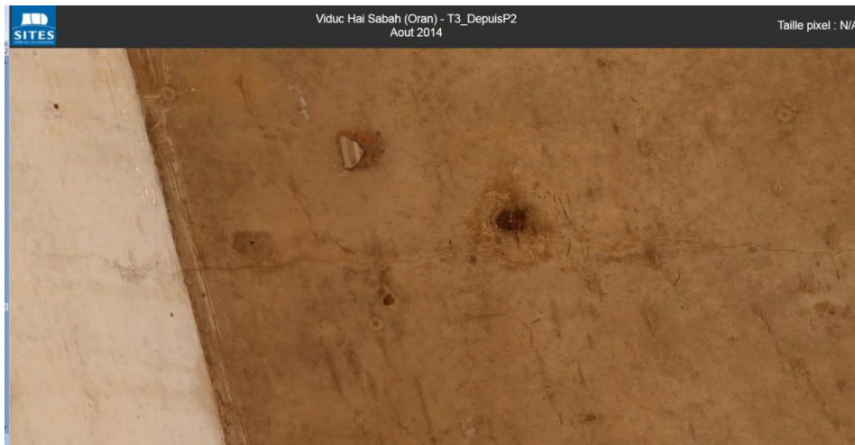
Tramway Oran Pont dalle en béton précontraint
