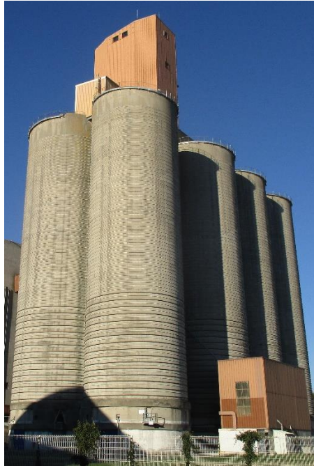
Vue générale des 8 silos
