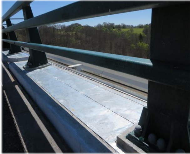
Protection cathodique des longrines par feuilles de zinc
