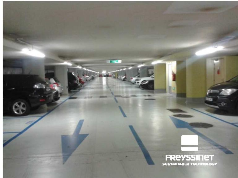
Une structure plancher béton sur poteaux et parois moulées périphérique
