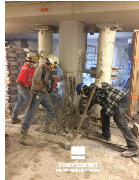
Purge complète du béton sur une hauteur en moyenne de 1,20 m
