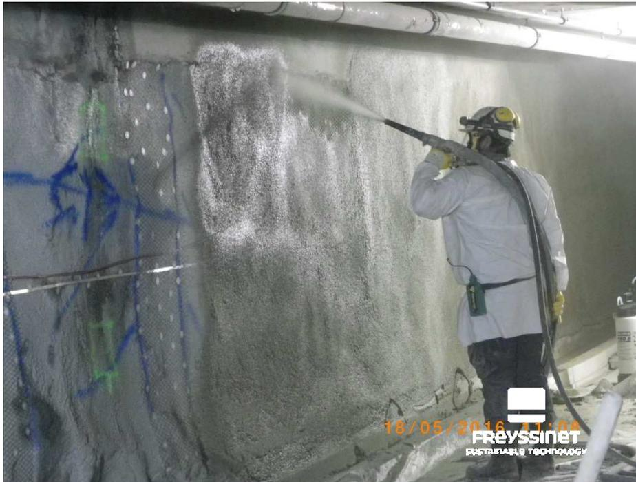
Réalisation de l'enrobage définitif par projection de mortier
