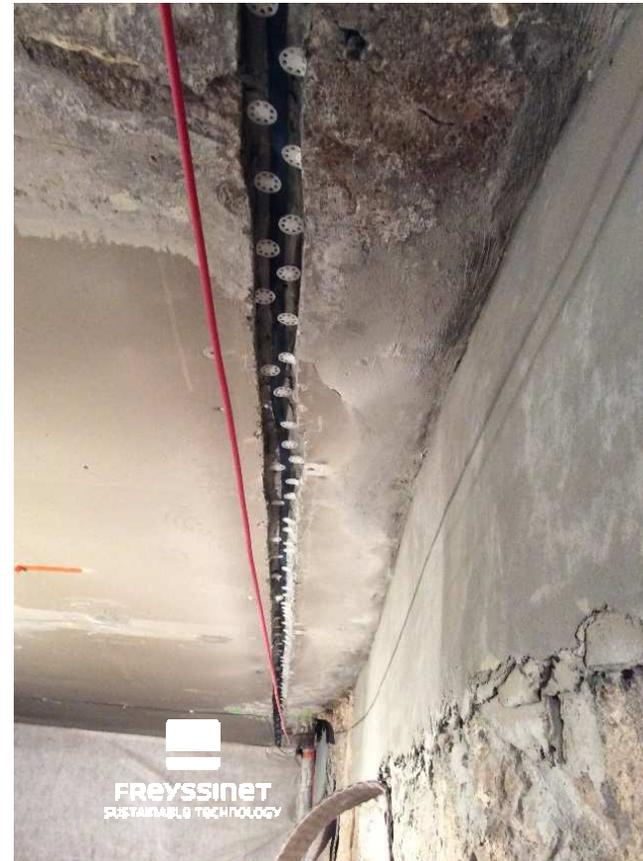
Ruban titane en fond de rainure avant rebouchage au mortier
