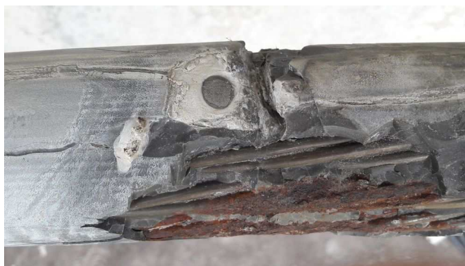
Ouverture et réparation >
