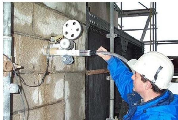
Forage horizontal dans la culée du pont
