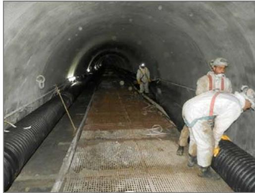
1) Pose du busage : un tuyau  $\varnothing 400$  mm sur chacune des banquettes
