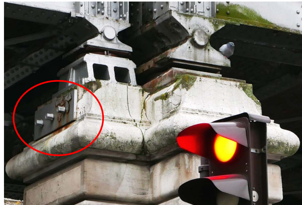
Exemple de confortement existant
