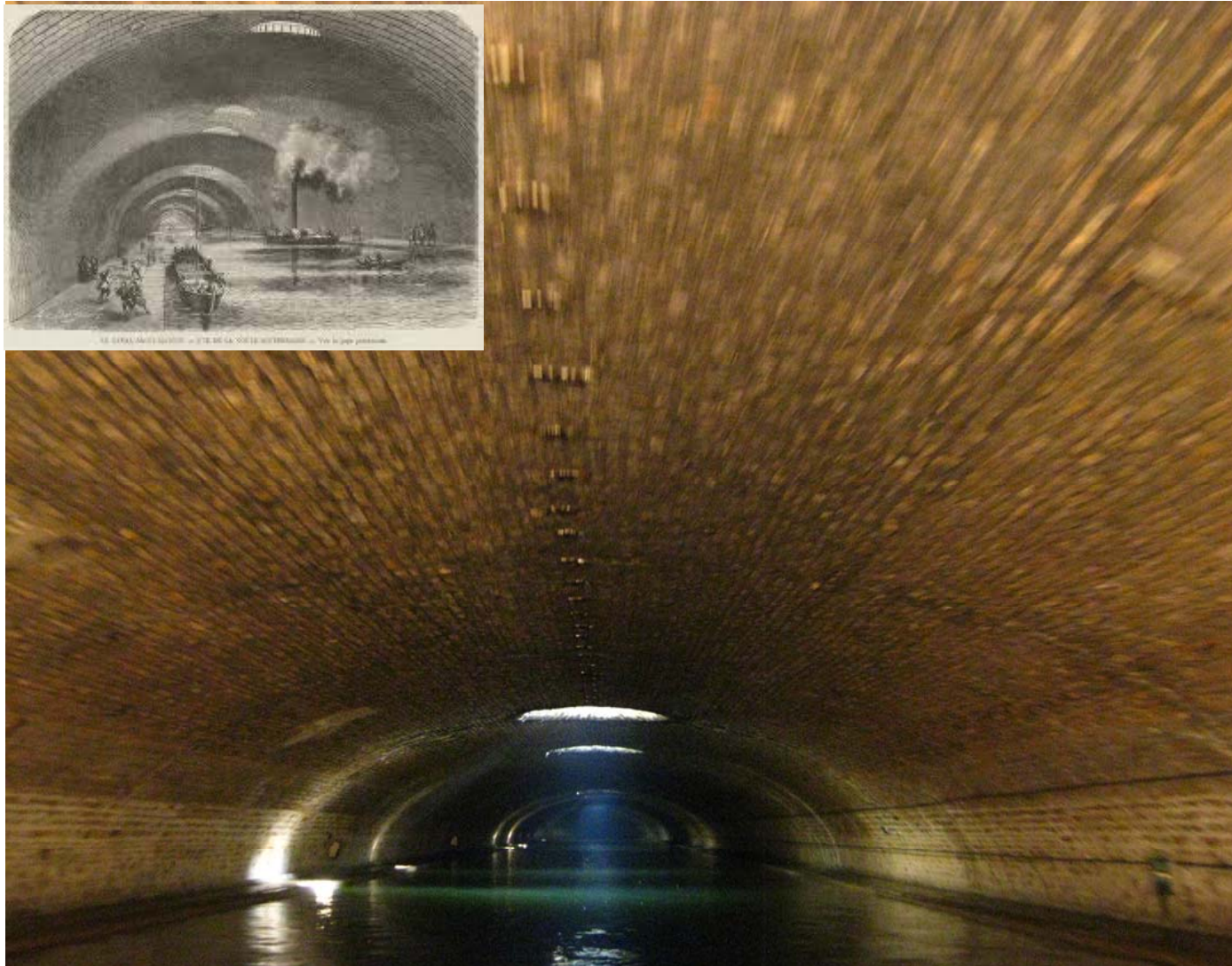
Adaptation des ouvrages en maçonnerie aux nouvelles conditions de service
