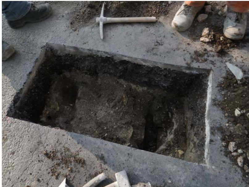
Réalisation de fouilles sur la chaussée
