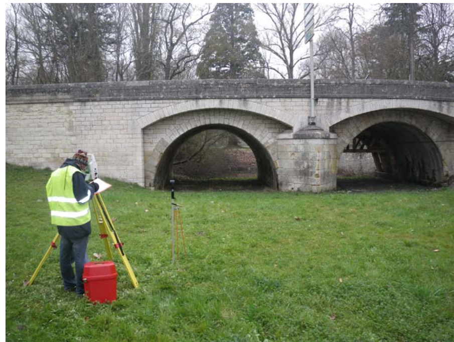
Relevé de la géométrie des voûtes par techniques topométriques
