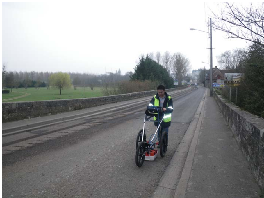
Reconnaitances : chaussée, auscultation RADAR
