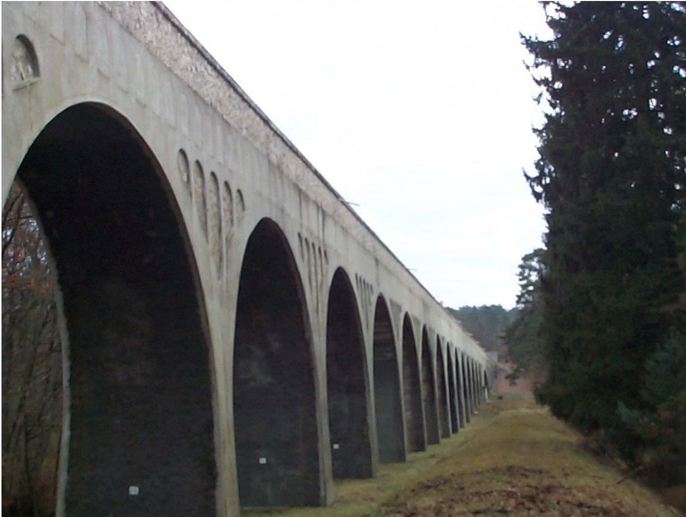
Adaptation des ouvrages en maçonnerie aux nouvelles conditions de service
