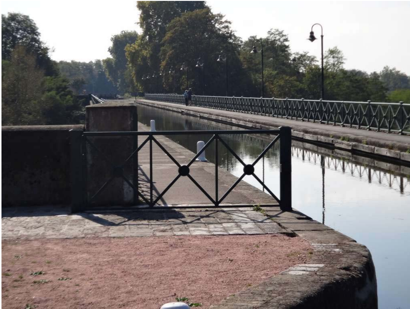
Pont canal de Digoin (Saône et Loire)
