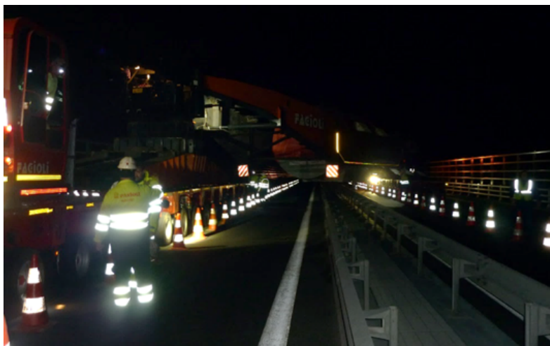
► Figure 6 : Passage en crabe d'un convoi exceptionnel de 560 t sur ouvrage d'art
