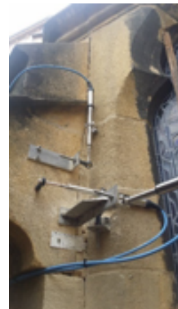
► Figure 12 : Précision requise de 0,05 mm - Surveillance d'un bâtiment historique
