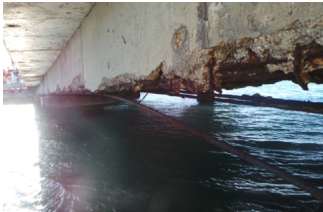
➤ Forte dégradation des poutres et appuis
