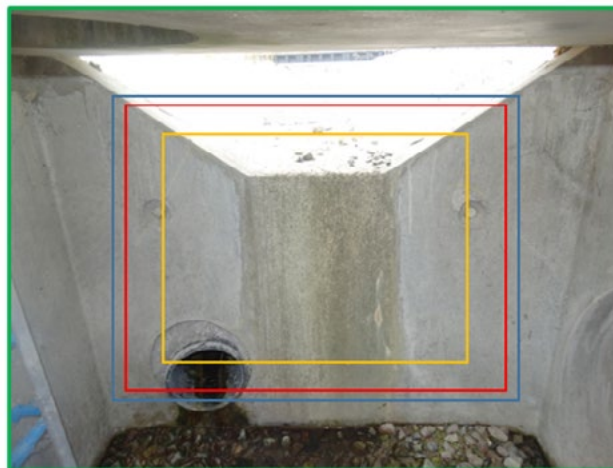
► Figure 30 : Relation entre la taille capteur et le champ image à focale constante
