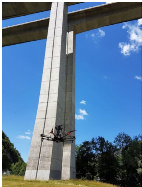
► Figure 35 : Drone au pied d'une pile de viaduc
