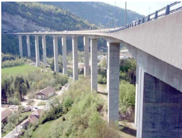
► Figure 34 : Viaduc de grandes dimensions surplombant une zone habitée
