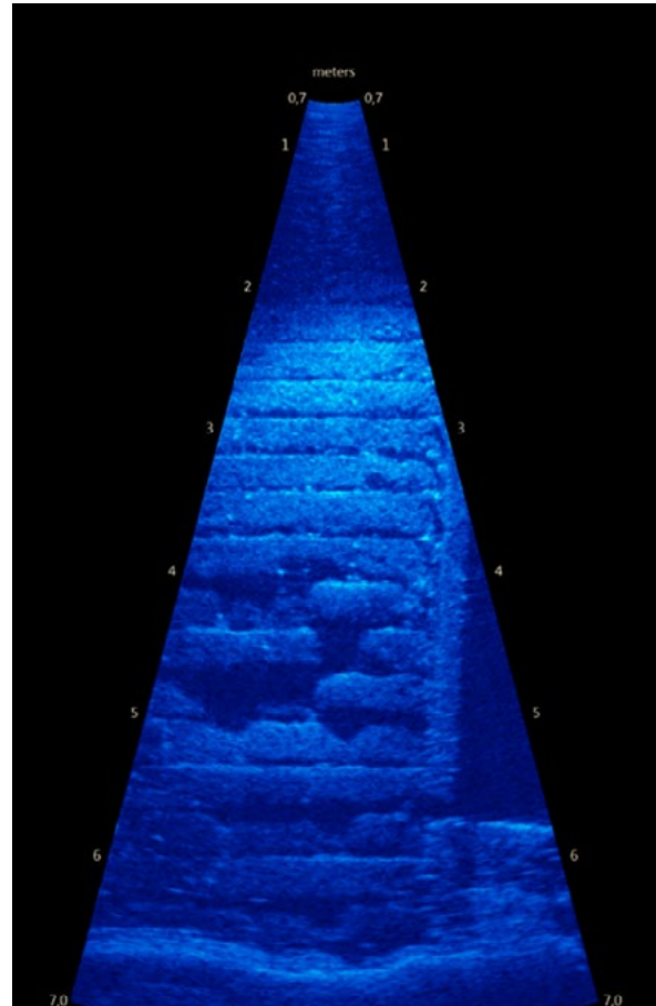
► Figure 12 : Parement maçonné par caméra acoustique
